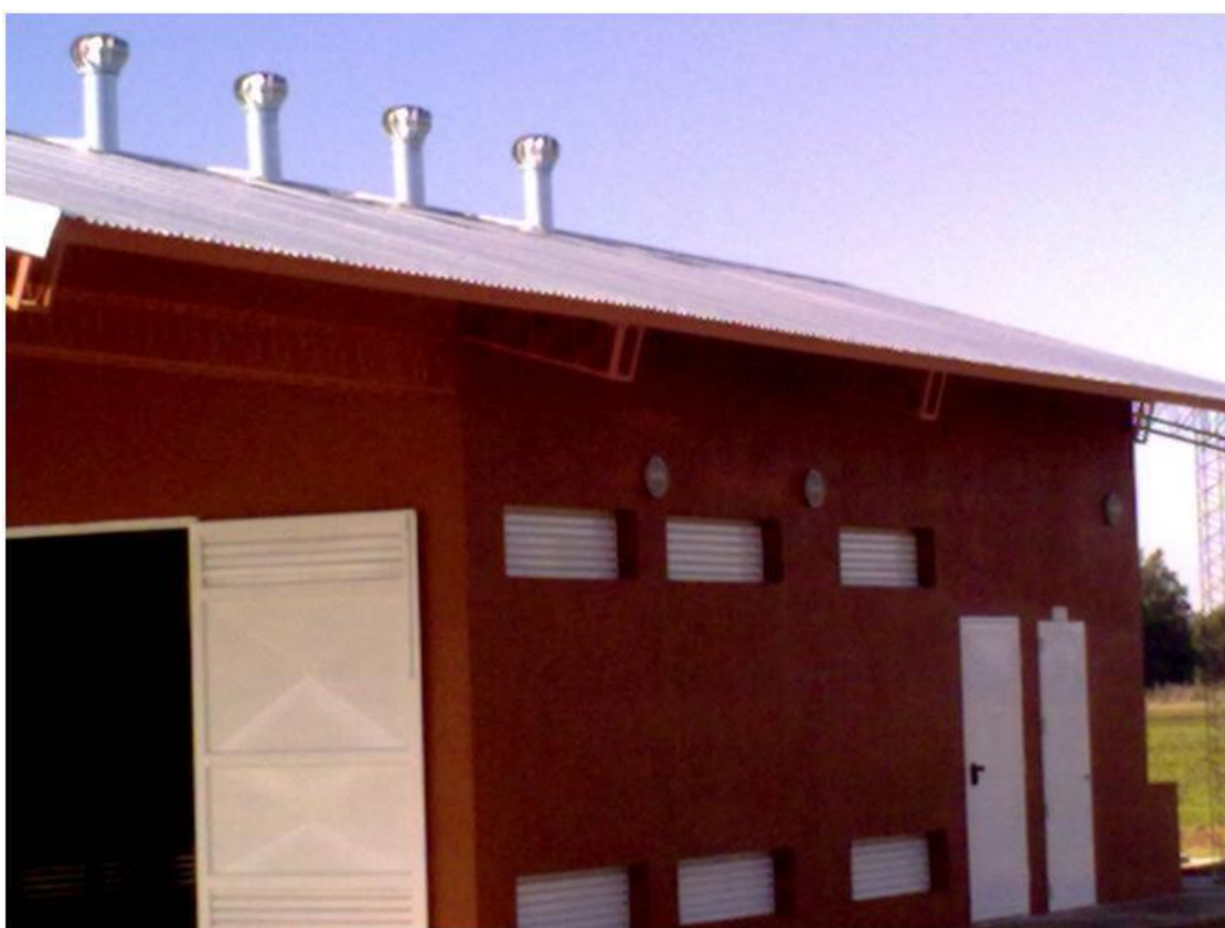
Depósito de agroquímicos de la EEA San Pedro. Es importante observar cómo están dispuestas las ventanas a distintas alturas y en el techo para favorecer la ventilación natural.
