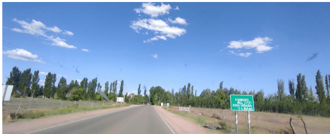
Foto 6: Vista del pavimento en buenas condiciones en la zona urbanizada del distrito 25 de Mayo.
