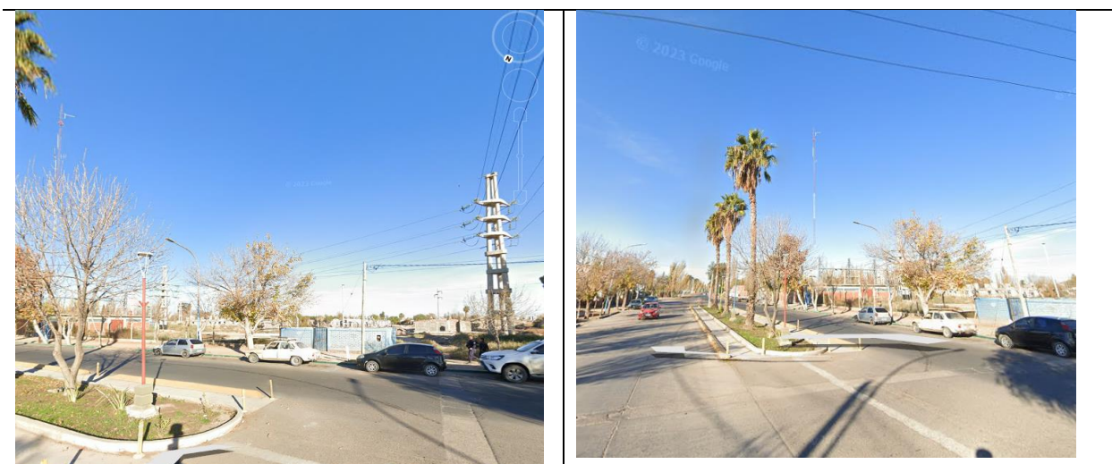
Figura N° 1: Foto de la actual Estación de Bombeo y del boulevard por donde irá la traza proyectada
