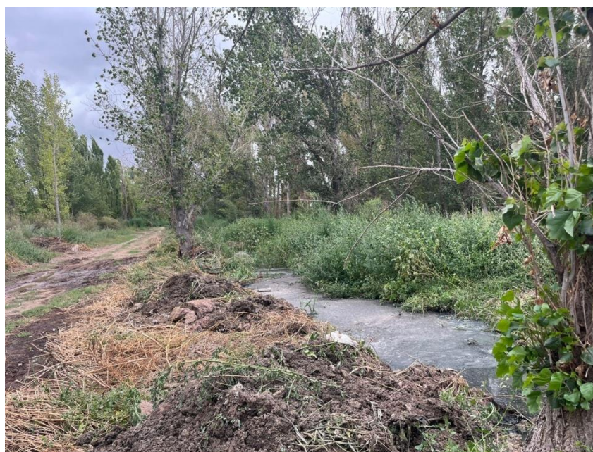
IMAGEN: LÍQUIDOS EN CAMPO DE DERRAME CALLEJON COLINDANTE
