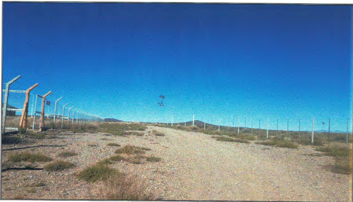
Fotografía N° 7 Ingreso al predio de la Central Térmica Punto de acceso al predio de la CT, vista al sur. A la izquierda -este- se observa Gas Andes.
