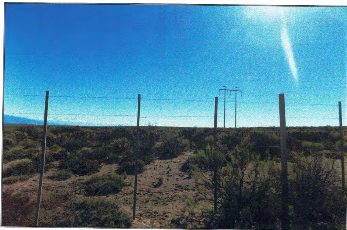
Fotografía N° 12 Vista desde la esquina nor-este del predio, hacia el norte Se observa el alambrado del perímetro norte y LAT.
