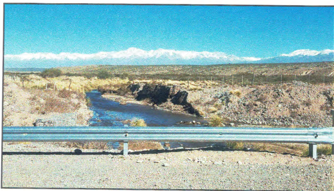
Fotografía N° 22 Arroyo Papagayos desde RN 40 Vista del arroyo desde la ruta, hacia el oeste.
