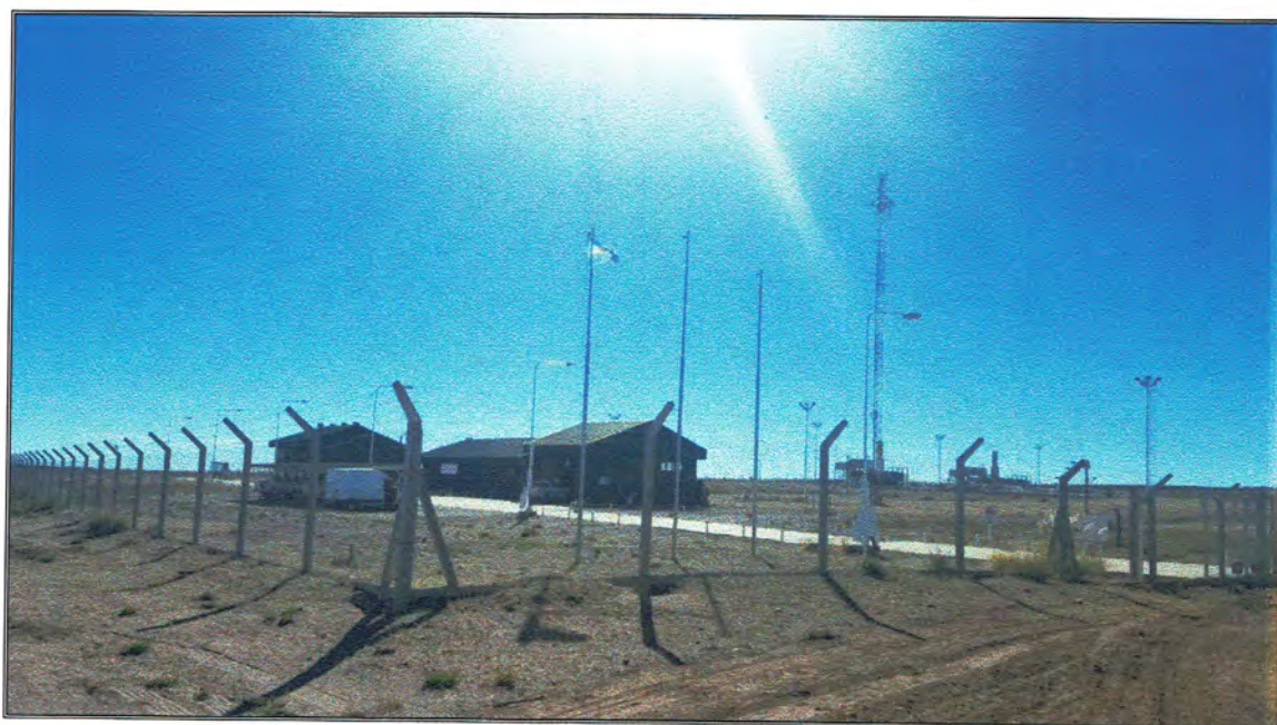
Fotografía N° 6 Vista de Planta Compresora de gas "Gas Andes" Vista desde esquina sur-oeste, hacia nor-este.
