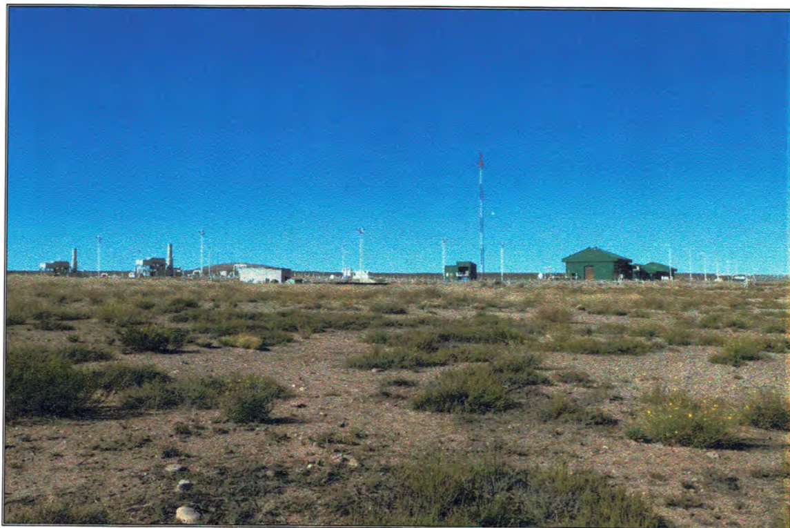
Fotografía N° 19 Vista desde la esquina nor-oeste del predio, hacia el sur-este Planta compresora de gas.
