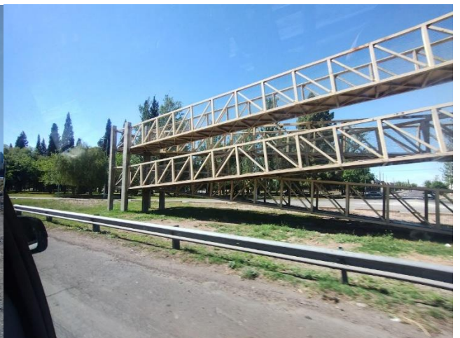
Foto N° 6 Pasarela peatonal Urquiza. Vista hacia el sur.
