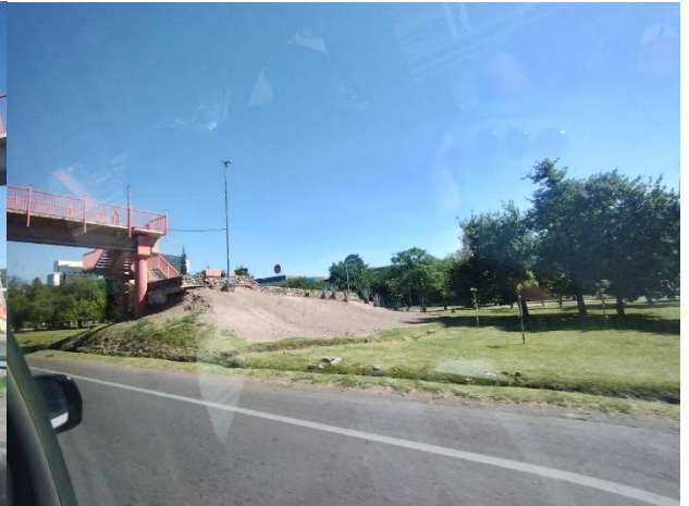
Foto N° 8 Pasarela peatonal. Frente a Mendoza Plaza Shopping. Vista hacia el norte
