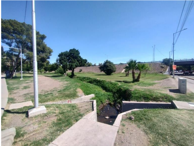
Foto N° 13 Obras de desagüe existentes
