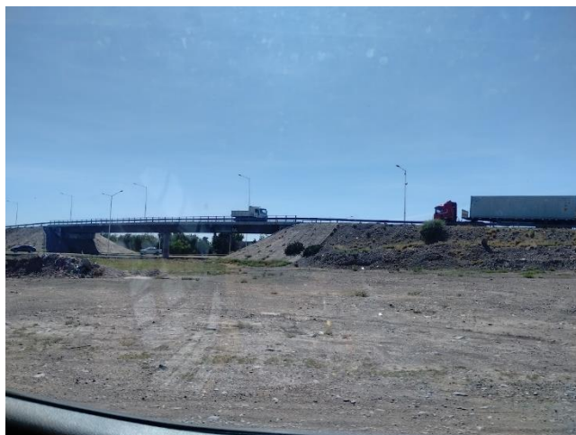
Foto N° 5 Puente Arturo González. Vista hacia el este. Extremo del proyecto de intervención.
