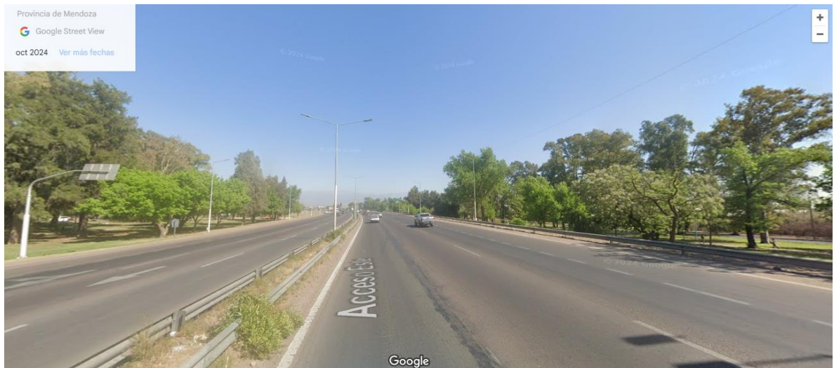
Figura 36: Tramo I – Vista al Sur desde lateral Este - Trayecto entre Estrada y Cañadita Alegre
