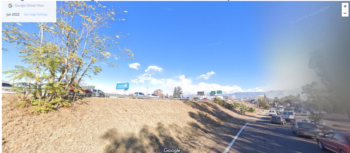
Figura 48: Tramo I – ingreso al AMM – vista hacia el Oeste – trayecto entre Alberdi y Costanera
