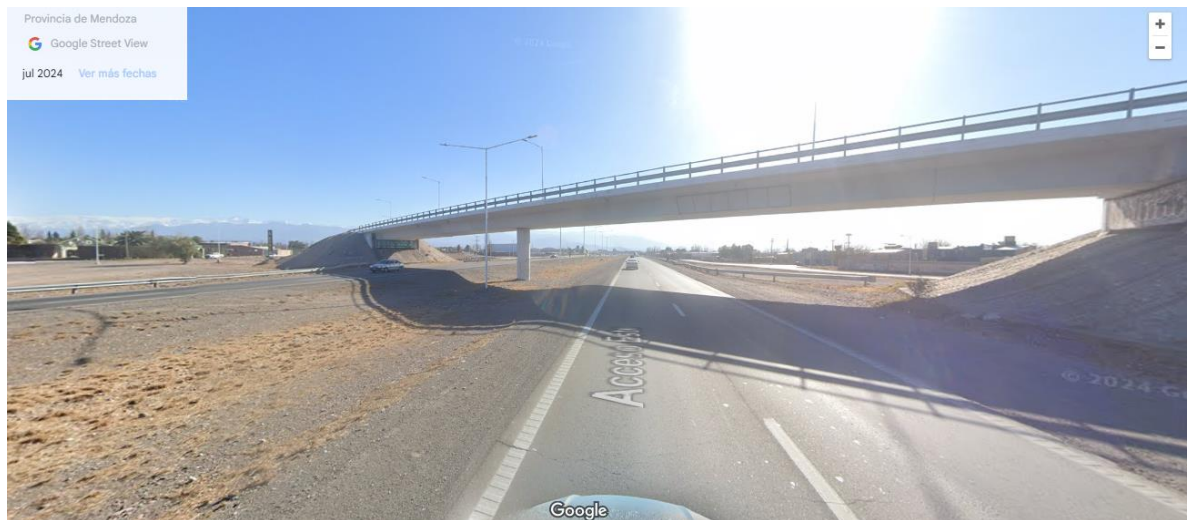
Figura 22: Tramo II – cruce calle Famatina – vista al Oeste
