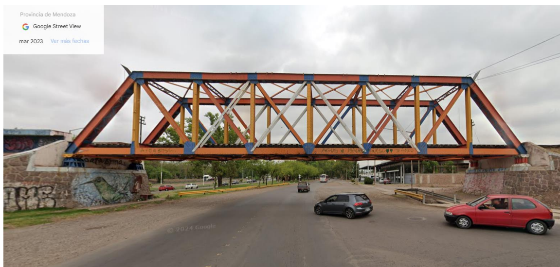
Figura 100: Puente de Hierro. Tramo II (intersección con calle La Purísima)
