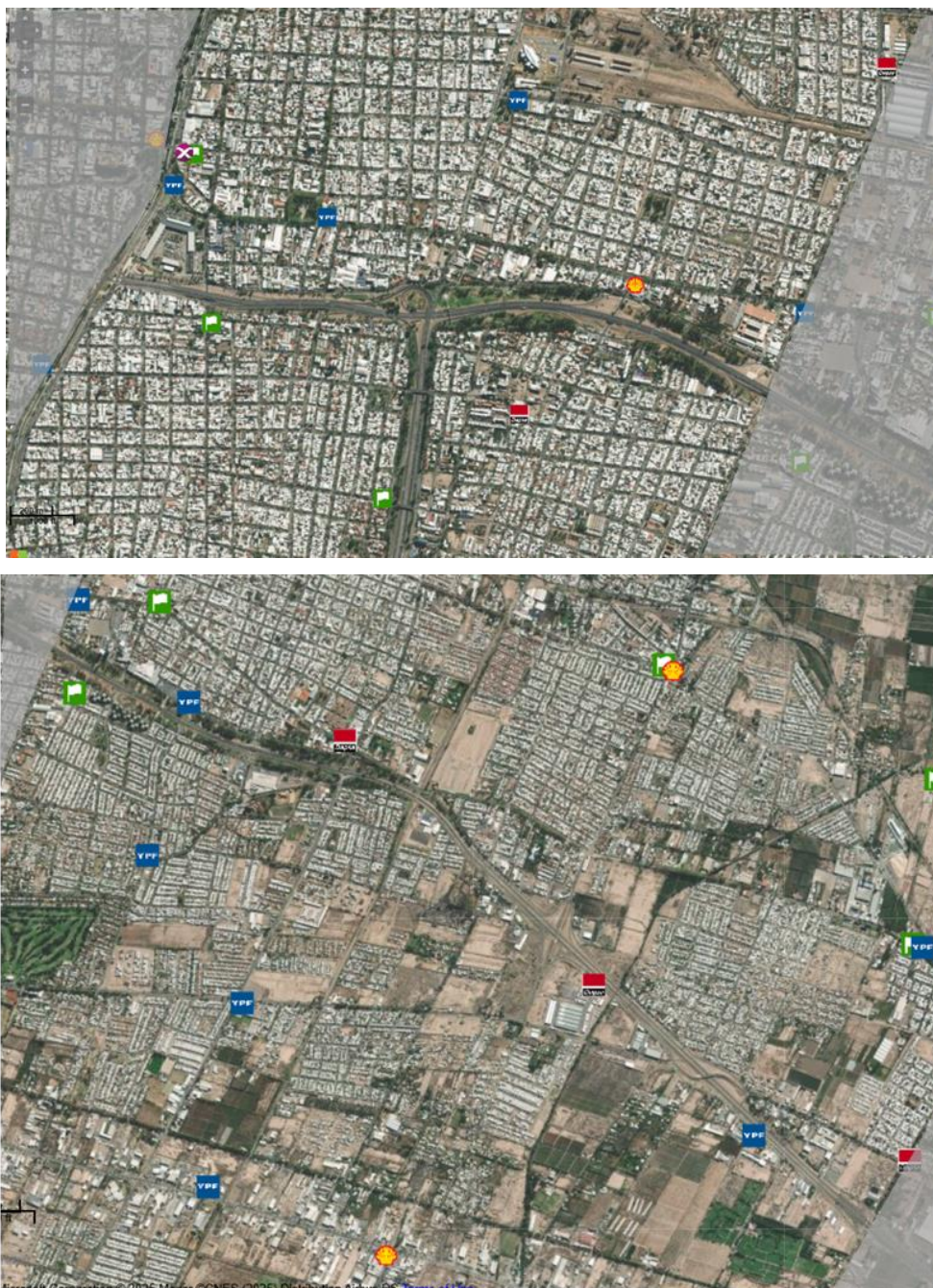
Figura 85: Estaciones de Servicio – Tramo I y II
