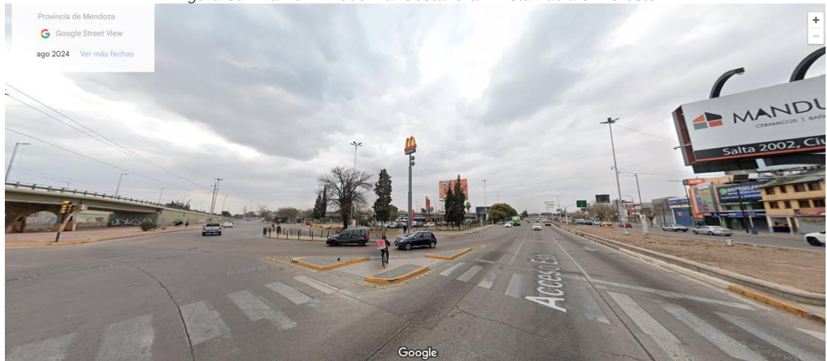
Figura 51: Tramo I – nudo vial Costanera – vista hacia el Este
