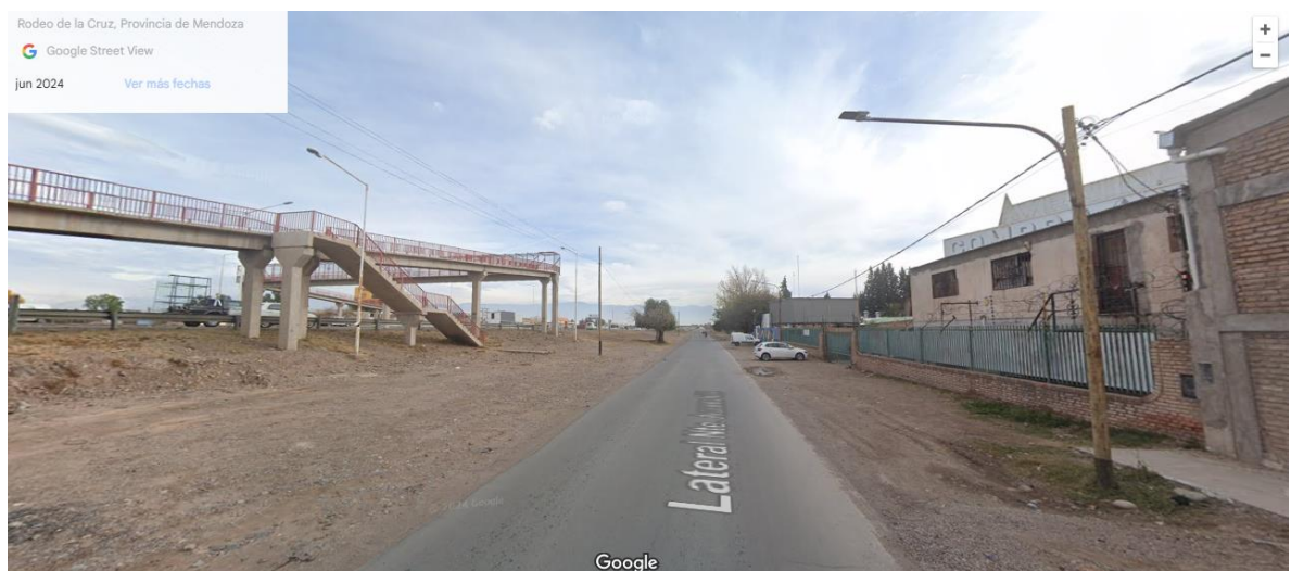
Figura 23: Tramo II – lateral norte entre Chacabuco y Arroyo
