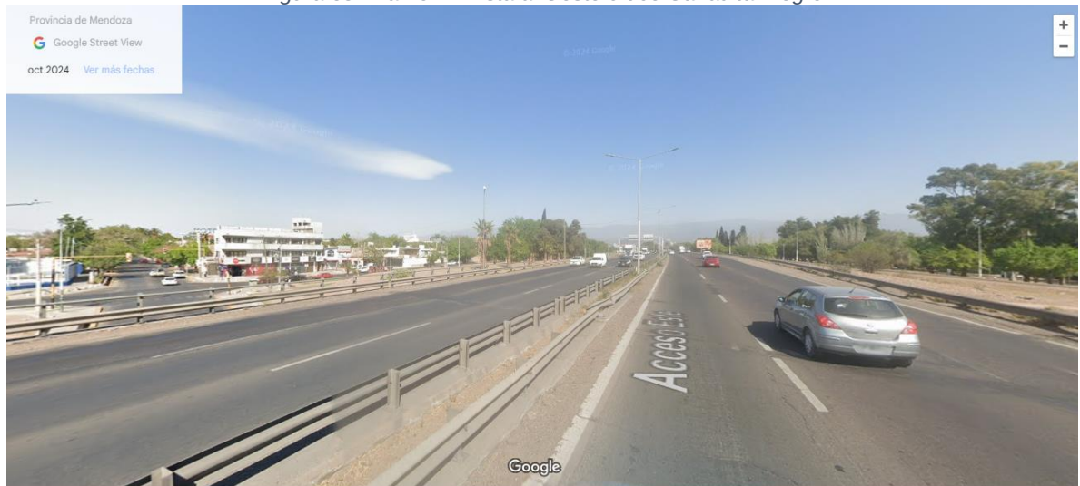
Figura 39: Tramo I – Vista al Oeste trayecto entre Cañadita Alegre y Mitre
