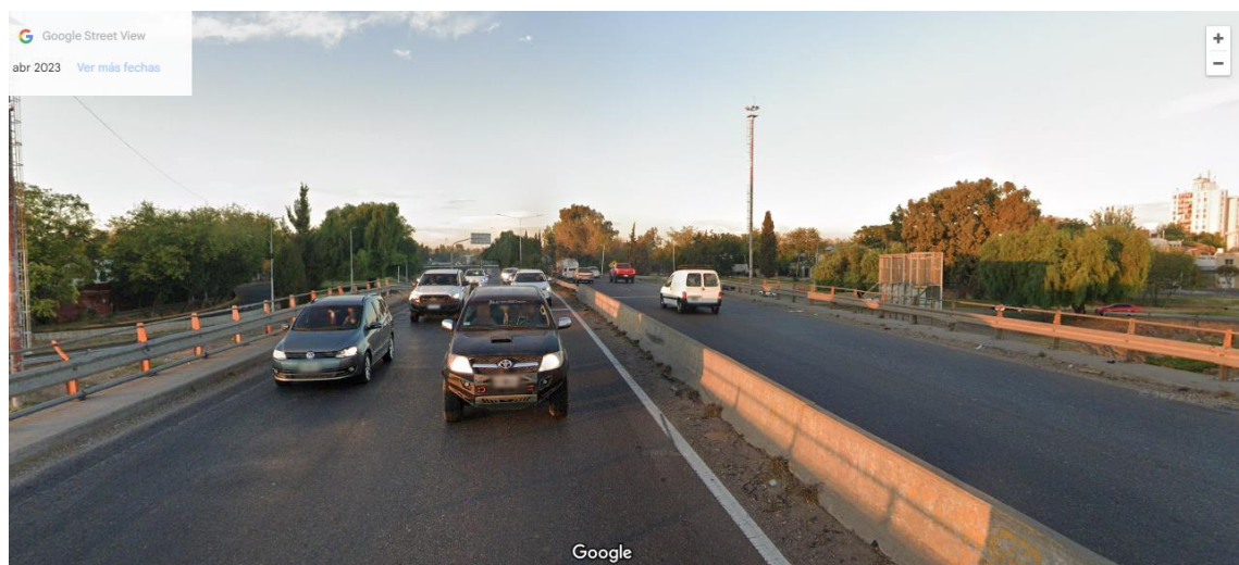
Figura 43: Tramo I – Nudo Vial cruce Acceso Este / Acceso Sur – vista hacia el Sur
