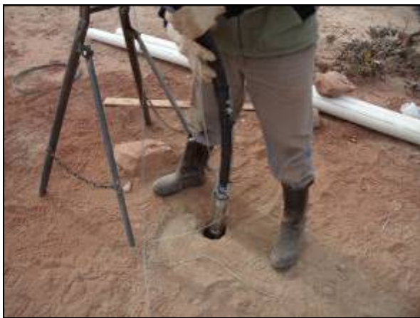
Encamisado e introducción de bomba
