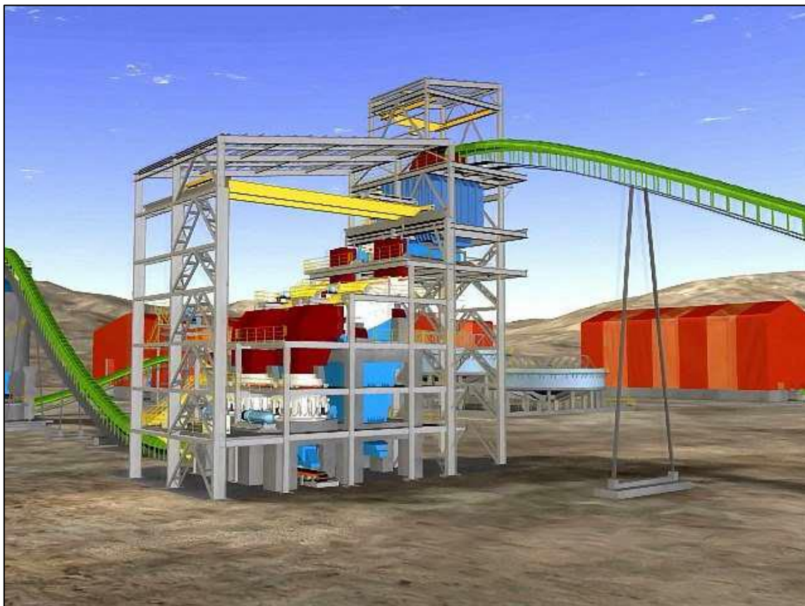
Figura 17.5 Vista del triturador terciario
